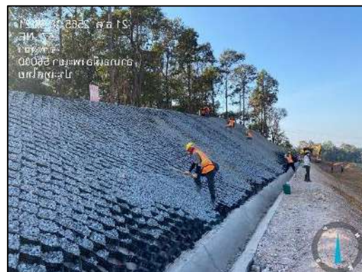
รูปที่ 2-66 กิจกรรมการติดตั้งโครงสร้างป้องกันการชะล้างพังทลายของดิน บริเวณปากอุโมงค์ช่วงที่ 2 จังหวัดพะเยา
