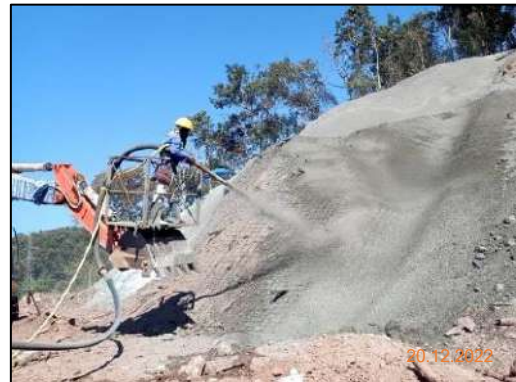
รูปที่ 2-66 (ต่อ) กิจกรรมการติดตั้งโครงสร้างป้องกันการชะล้างพังทลายของดิน บริเวณปากอุโมงค์ช่วงที่ 2 จังหวัดพะเยา
