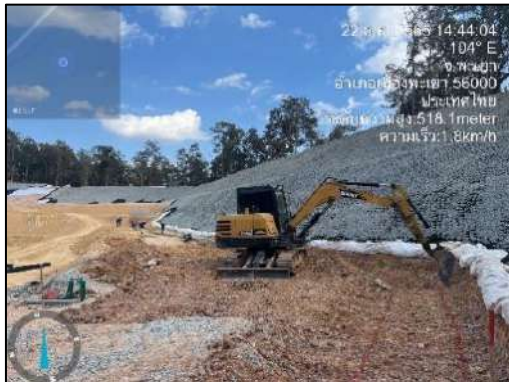
รูปที่ 2-66 (ต่อ) กิจกรรมการติดตั้งโครงสร้างป้องกันการชะล้างพังทลายของดิน บริเวณปากอุโมงค์ช่วงที่ 2 จังหวัดพะเยา
