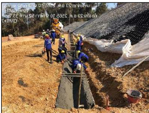
รูปที่ 2-66 กิจกรรมการติดตั้งโครงสร้างป้องกันการชะล้างพังทลายของดิน บริเวณปากอุโมงค์ช่วงที่ 2 จังหวัดพะเยา
