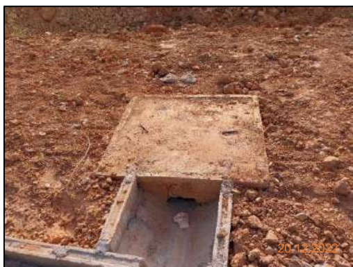
รูปที่ 2-52 ช่องทำความสะอาดท่อในแนวนอน (Cleanout) และช่องทำความสะอาดท่อนพื้น (Floor Cleanout)
