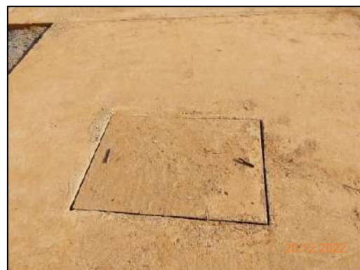
รูปที่ 2-52 ช่องทำความสะอาดท่อในแนวนอน (Cleanout) และช่องทำความสะอาดท่อนพื้น (Floor Cleanout)
