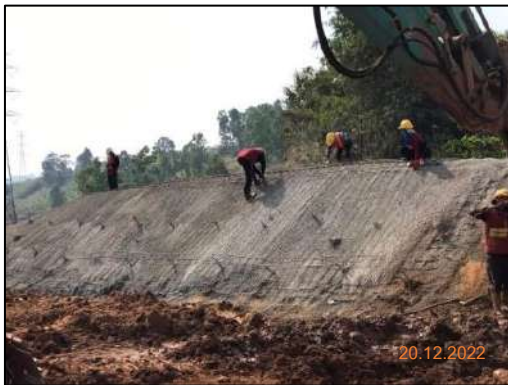
รูปที่ 2-65 กิจกรรมการเตรียมพื้นที่สำหรับติดตั้งโครงสร้างป้องกันการชะล้างพังทลายของดิน บริเวณบ้านพักคนงาน จังหวัดพะเยา
