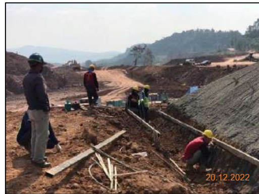
รูปที่ 2-65 กิจกรรมการเตรียมพื้นที่สำหรับติดตั้งโครงสร้างป้องกันการชะล้างพังทลายของดิน บริเวณบ้านพักคนงาน จังหวัดพะเยา
