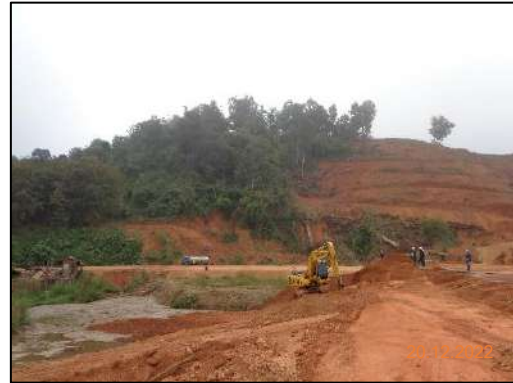
รูปที่ 2-65 กิจกรรมการเตรียมพื้นที่สำหรับติดตั้งโครงสร้างป้องกันการชะล้างพังทลายของดิน บริเวณบ้านพักคนงาน จังหวัดพะเยา
