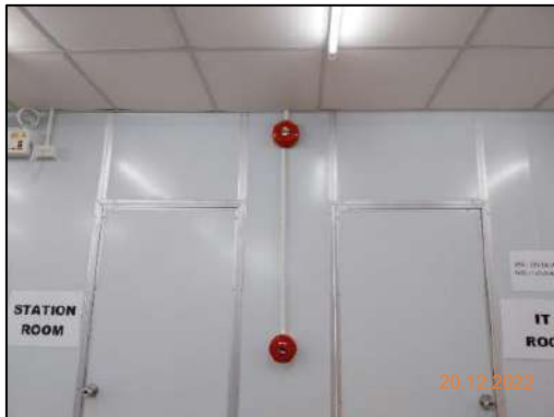
รูปที่ 2-61 สัญญาณแจ้งเหตุเพลิงไหม้
