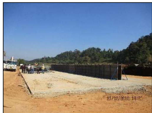
รูปที่ 2-67 กิจกรรมการผูกเหล็กและหล่อคอนกรีต เพื่อทำคานสะพาน บริเวณบ้านพักคนงาน จังหวัดพะเยา
